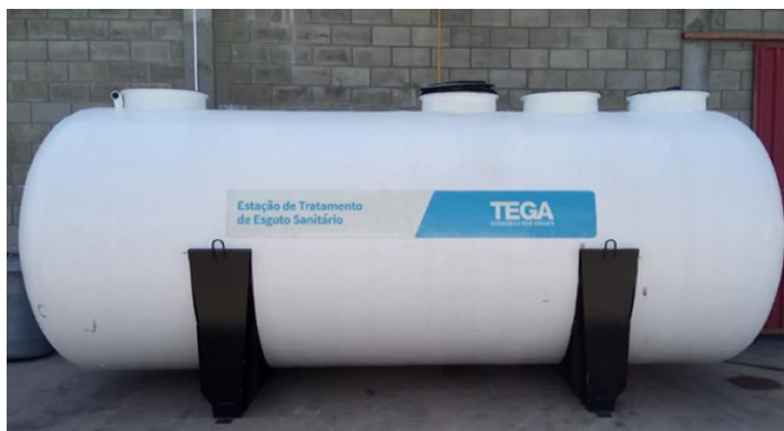
Figura 1: Modelo do tanque da ETE Compacta
