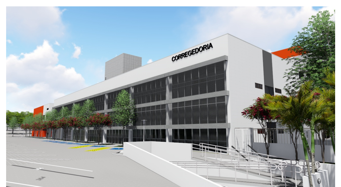
vista norte do prédio da corregedoria TJ/PI
