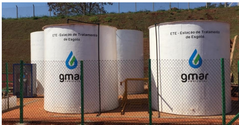
Figura 2: Modelo do sistema da ETE Compacta (GMAR ou similar).
