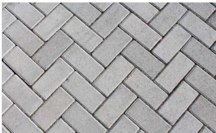
Figura 41: Modelo de piso intertravado com bloco retangular.
