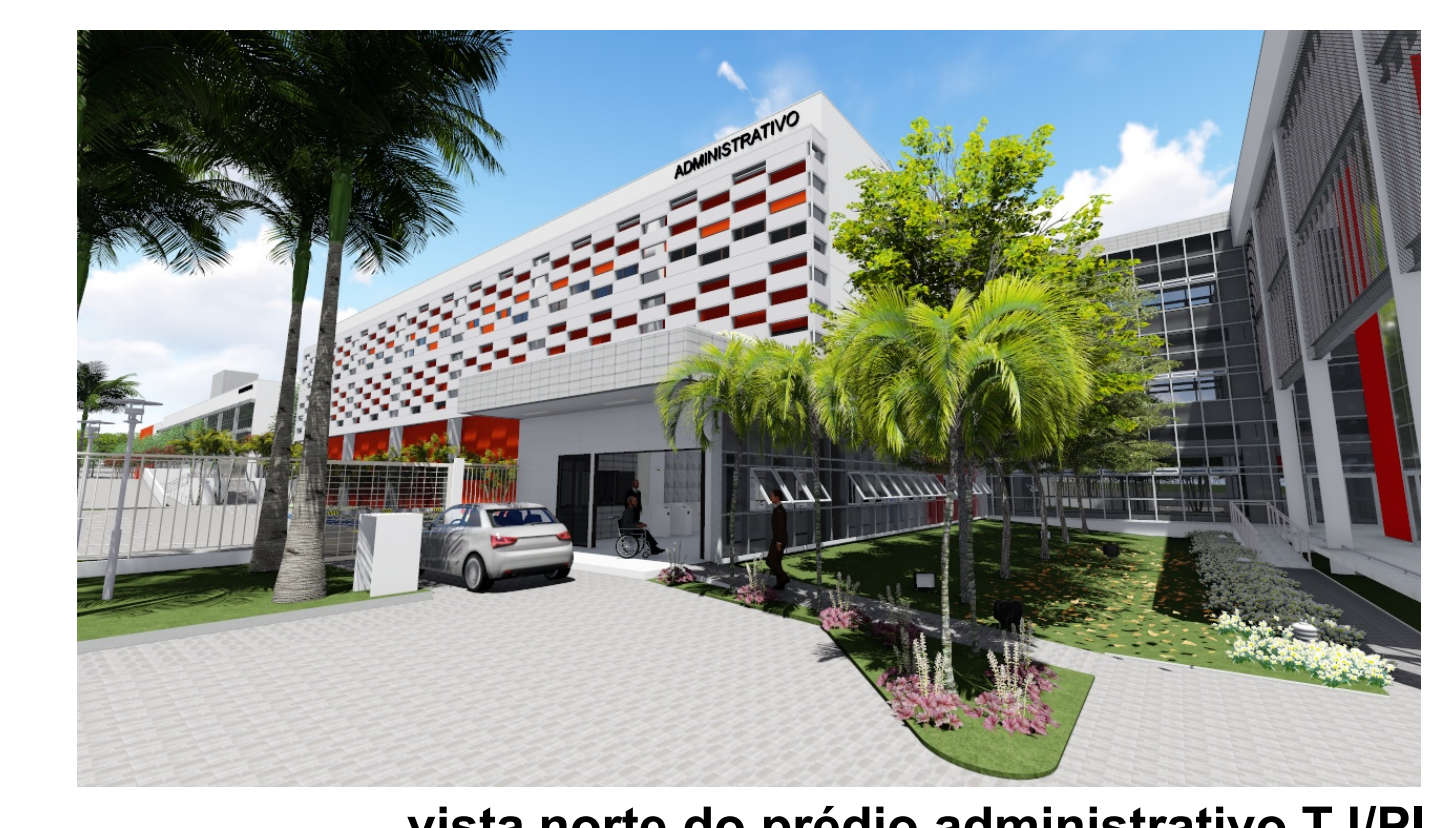
vista norte do prédio administrativo TJ/PI
