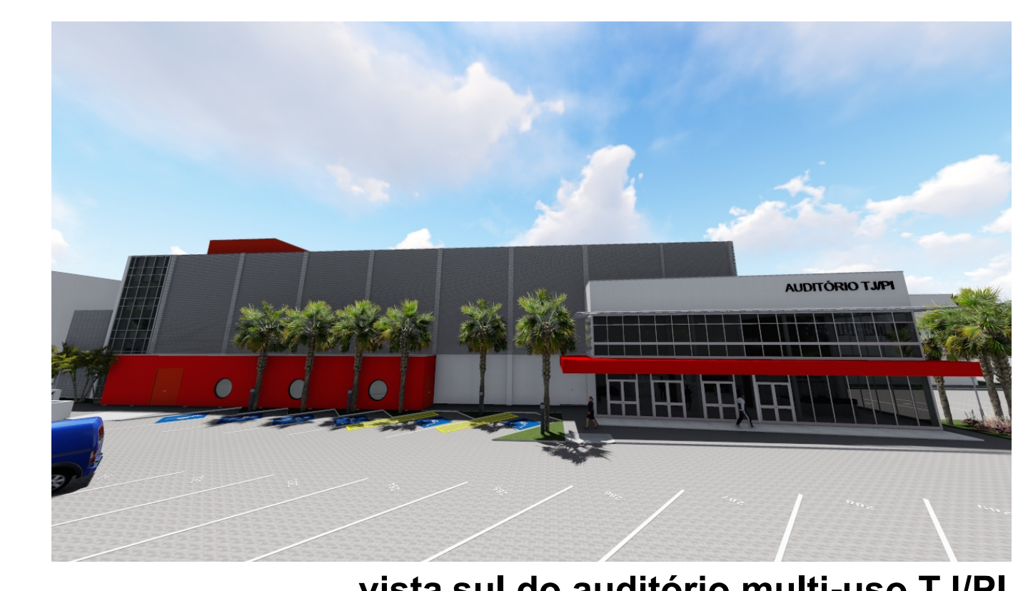
vista sul do auditório multi-uso TJ/PI
